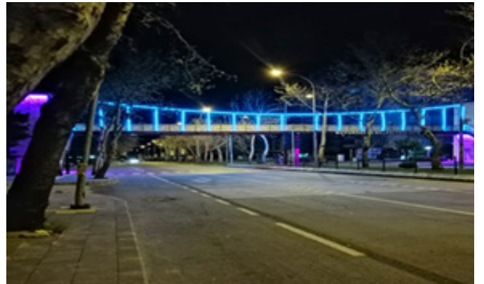
12 Şubat İlçesinde bulunan üstgeçit mavi ışıkla aydınlatıldı
